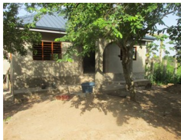
Das Gebäude ist fast fertig.
