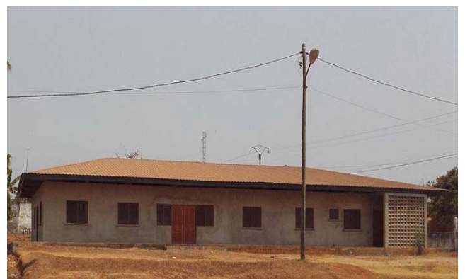
Im Bau befindliche Mutter-Kind Station
