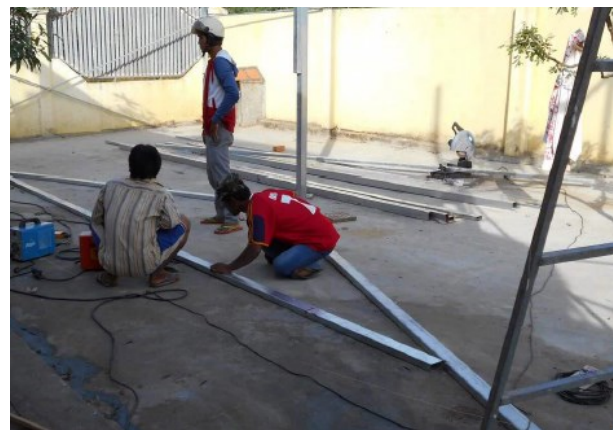
Die Dachkonstruktion wird errichtet.
